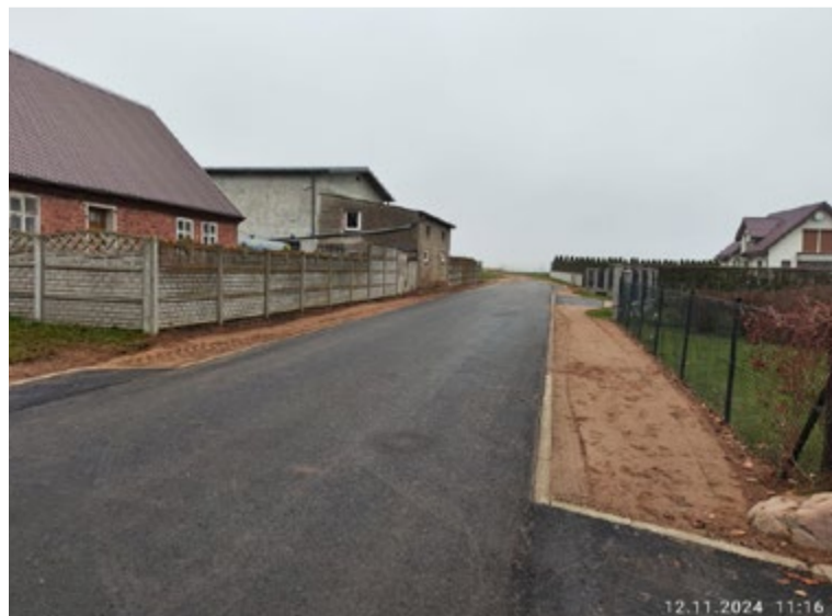
Fot. Gmina Nowa Wieś Lęborska - droga w Krępie Kaszubskiej
