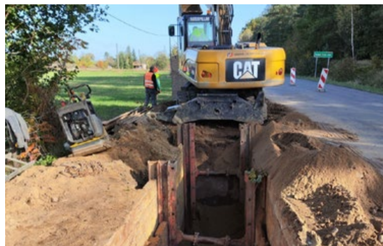
Fot. Gmina Nowa Wieś Lęborska - budowa kanalizacji sanitarnej
