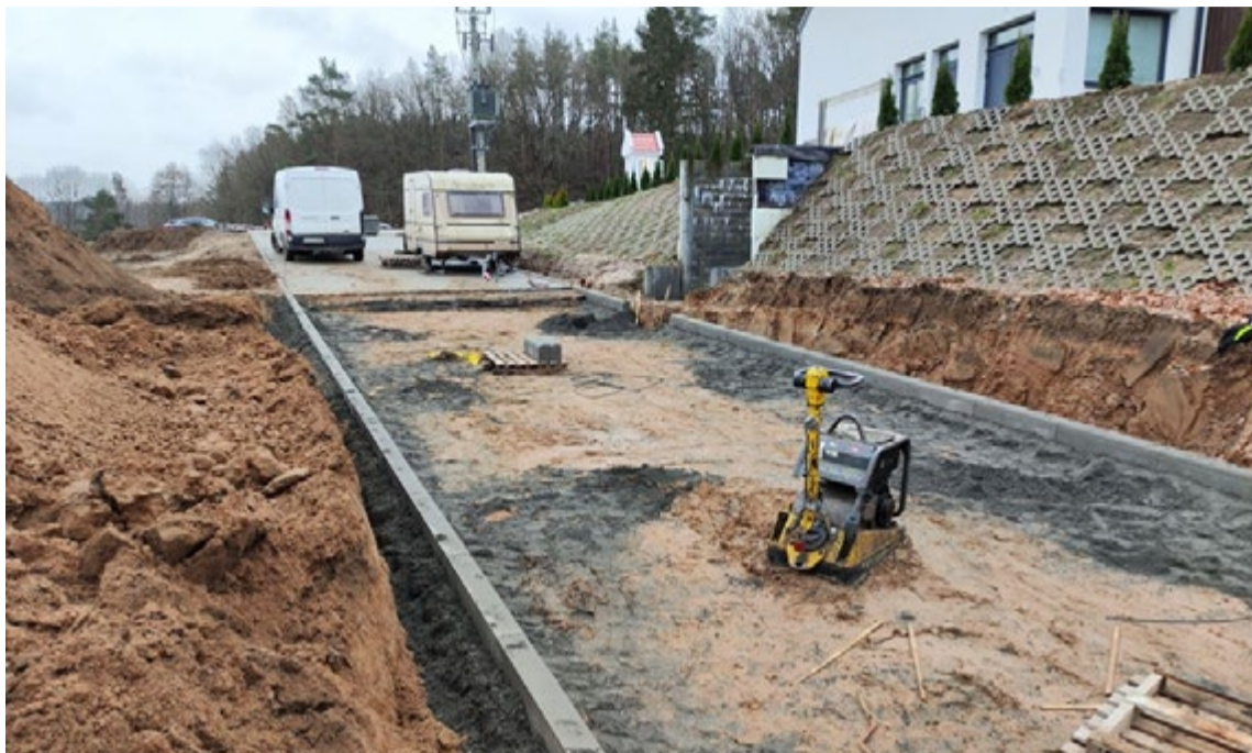
Fot. Gmina Nowa Wieś Lęborska - budowa drogi do hospicjum
