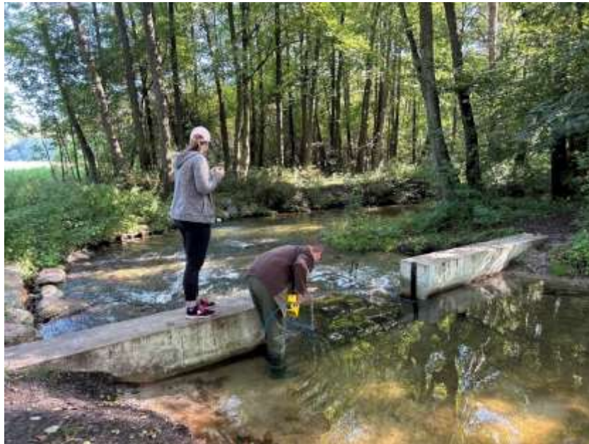
Fot. 2. Zastawka do regulacji poziomu wody w jeziorze Lubowidzkim usytuowana na odpływie
